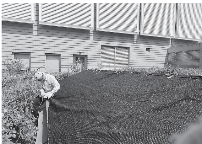
常設展示室における保存環境改善を目的とした寒冷紗の設置作業
